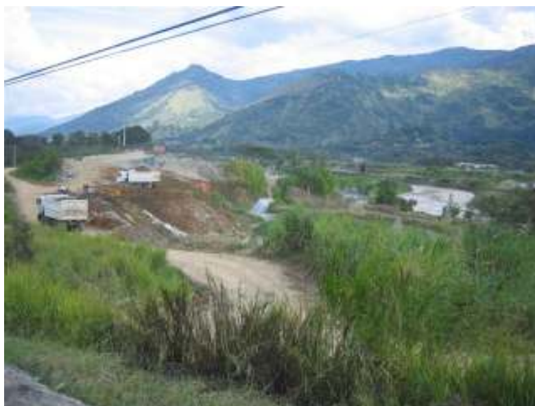
Figura 8. Evidencia de la afectación al recurso hídrico por las labores mineras. Municipio de Copacabana
