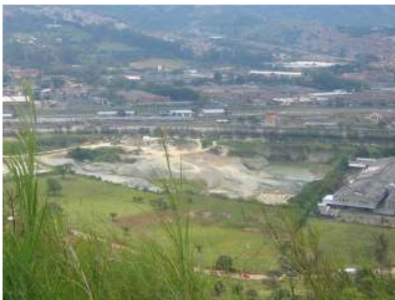
Figura 9. Lagos dejados por la explotación minera. Municipio de Bello.
