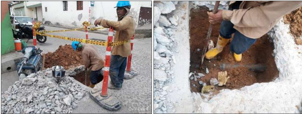
Figura 11. Apique de validación realizado en la red del municipio de Piedecuesta
