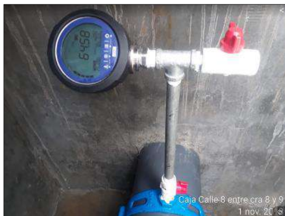
Figura 26. Medición de presiones en uno de los siete puntos de la red.
