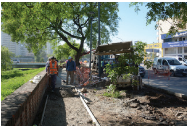
Obra sobre Costanera Sur (noviembre 2018)
