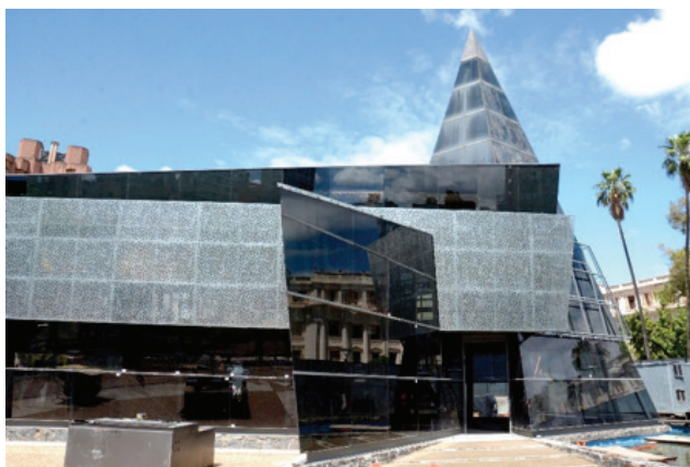
Obra en La Casa del Futuro (noviembre 2018)
